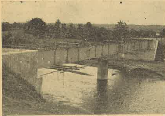
◆ 15号橋(仮称)架換工事 昭和37年から2か年計画 工事費総額 2,060万円で建設されておりますが、8月に竣工する予定です。 橋長 50.3m 巾員 6.5m (完成間近かな15号橋(仮称))
