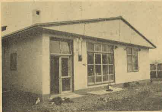
◆ 清里小・中学校長住宅新築工事 簡易耐火構造平屋建2棟2戸が6月に完成しました。 工事費は1棟1戸105万円、2戸で210万円 構造は2戸とも同じです。 (できあがった清里中校長住宅)
