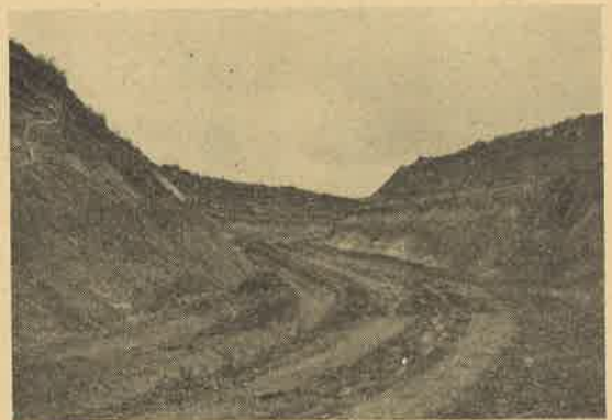
◆ 20号道路改良工事 農業構造改善事業の一つとして行われております。 8月竣工予定 延長 5.095m 巾員 4.0m (竣工間近かな20号道路)
