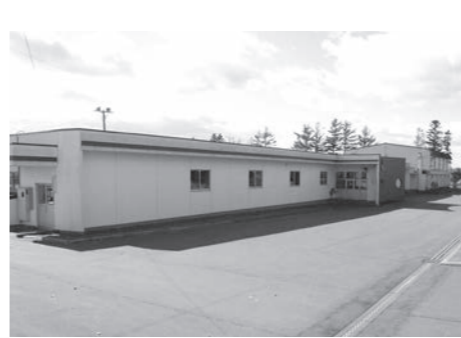
【旧光岳小学校教職員住宅解体工事】
