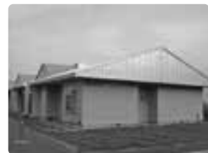
さくらんぼ団地 (公営住宅)
